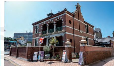
(上)変化に富む関門海峡は発見と驚きの連続。キャプテンは操船の満足感、ゲストは非日常を味わうことができる (下)旧下関英国領事館。明治39年に建てられた現存する最古の領事館建築物
