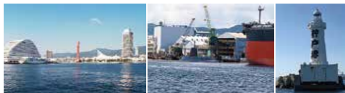
みなと神戸 大型タンカーや潜水艦の建造風景
